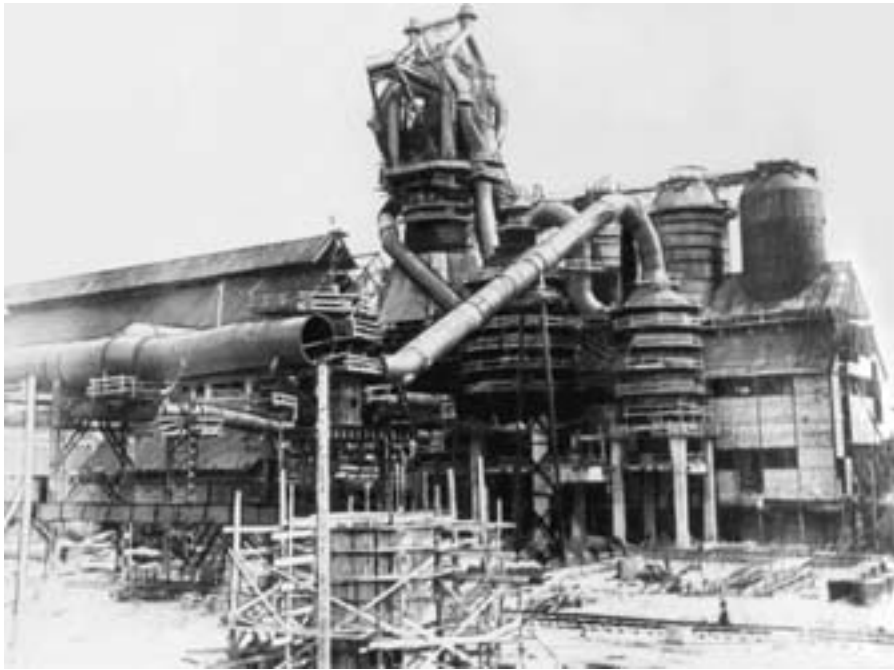
Строительство доменной печи № 1 НТМЗ. 1939 г.
