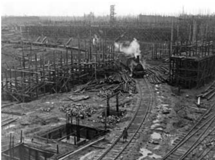
Панорама строительства Новотагильского металлургического завода. 1938 г.
