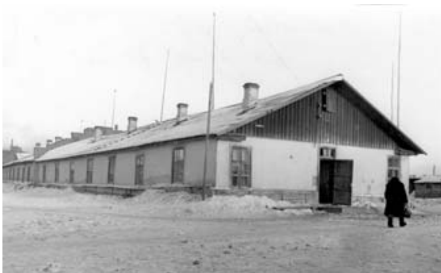
Барак № 7 в посёлке Домнострой, в котором проживали 28 семей строителей НТМЗ. Середина 1930-х гг.
